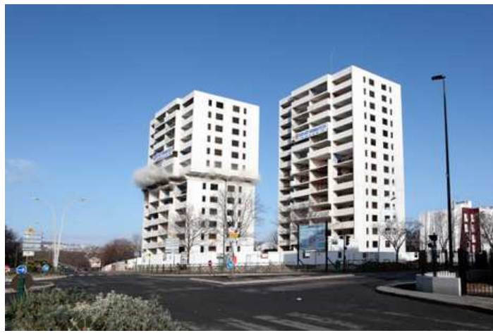
Démolition tours Mondor
