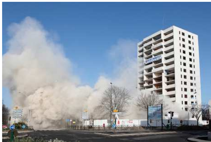
Démolition tours Mondor 3
