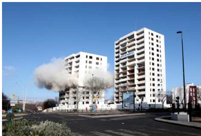
Démolition tours Mondor 2
