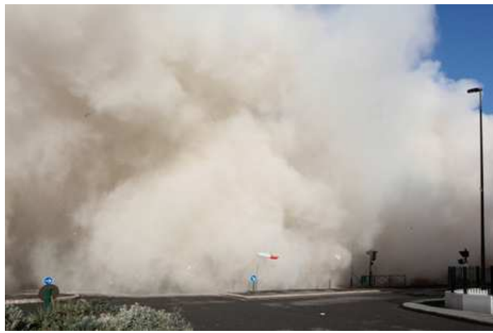
Démolition tours Mondor 4
