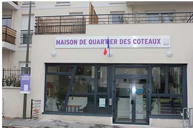
Une nouvelle Maison de Quartier sur l'avenue Joffre
