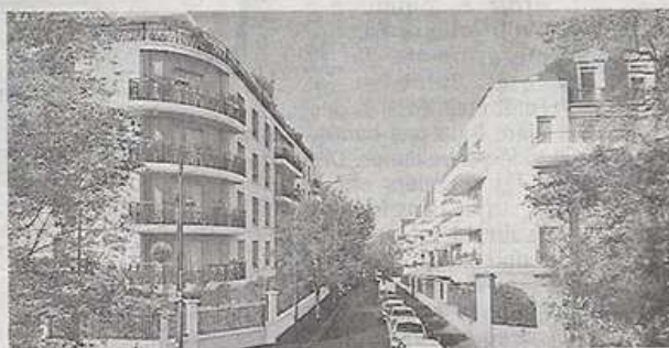
D'après une simulation 3D réalisée par les riverains du Petit-Marly, voilà à quoi ressemblera leur rue si le projet d'immeuble de cinq étages (à g.) est retenu.
